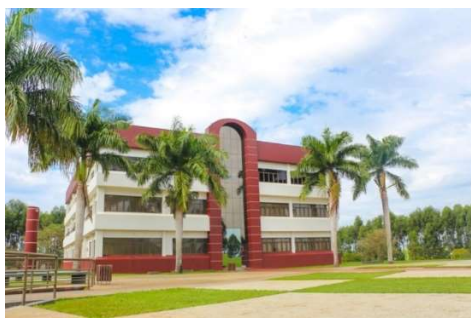
Figura 27 Prédio da Faculdade de Teologia do Paraná Fonte: acervo do site FAP
