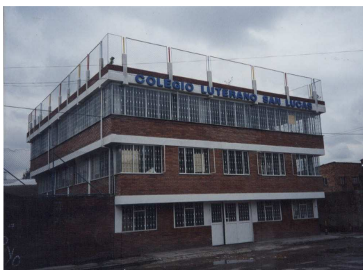
Colegio Luterano San Lucas edificio nuevo donde funciona la secundaria
